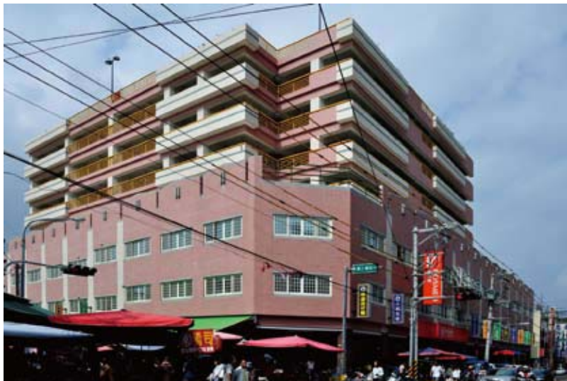
「安東里本街」完工照片（丁致成攝）
